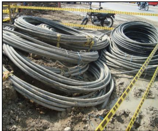
Tuberías para cambio de las diferentes redes de servicios públicos
