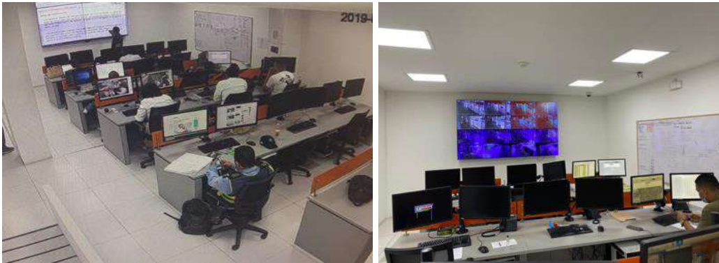
Ilustración 5. Centro de Control de Operaciones - CCO Transcaribe S.A
